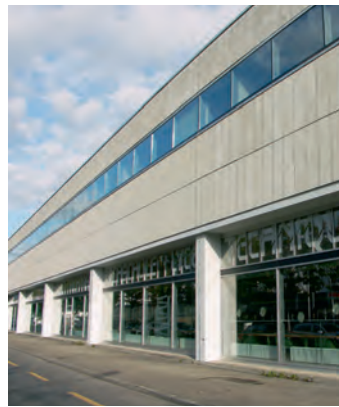
Salzhausstrasse Rue de la Gabelle
