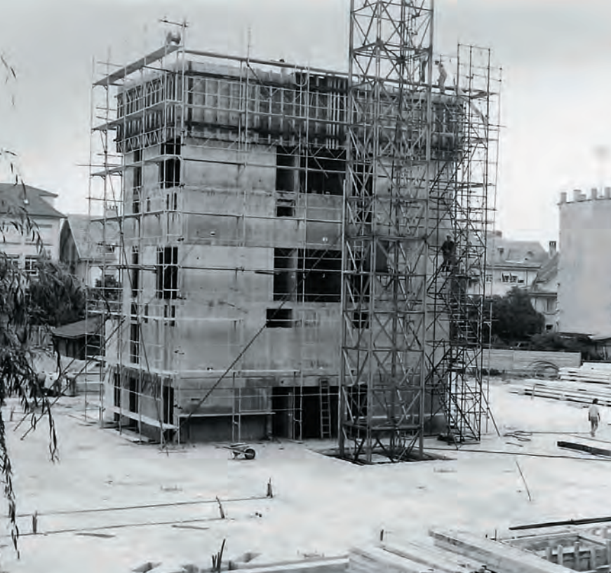
Gebäude 9 im Bau
