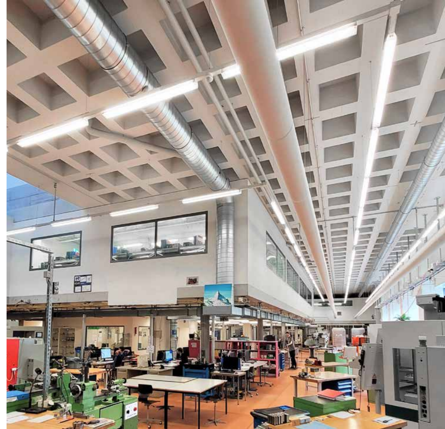
Blick vom Erdgeschoss zum Zwischengeschoss und zur Elektronik-Abteilung
