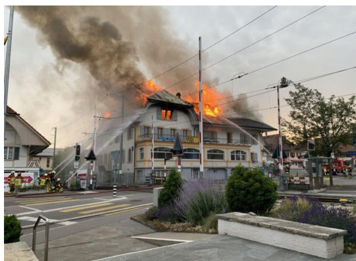
Der Dachstock des «Bären» brannte gestern lichterloh. ZVG
